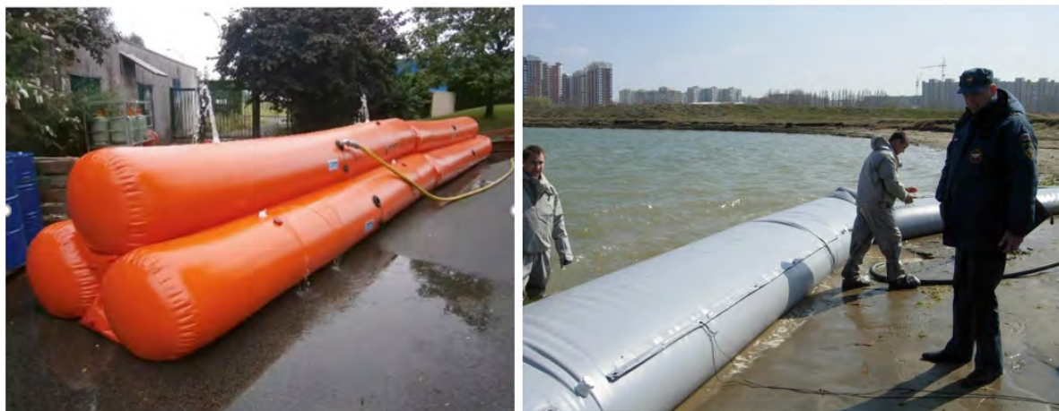
Рис.2. Водоналивные рукавные противопаводковые дамбы
